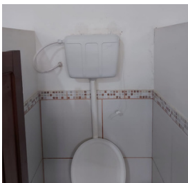
Substituição de caixas de descarga nos vestiários
