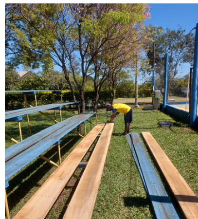
Reforma Arquibancada Quadras
