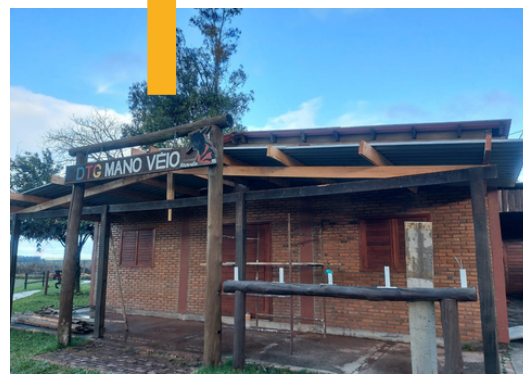
Troca telhado frente DTG
