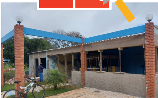
Reforma e aumento do Bar da Piscina
