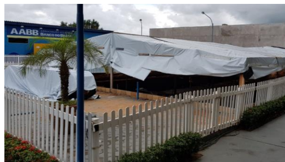
Obras do parque aquático.
