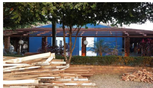
Visão central externa – sede em reforma
