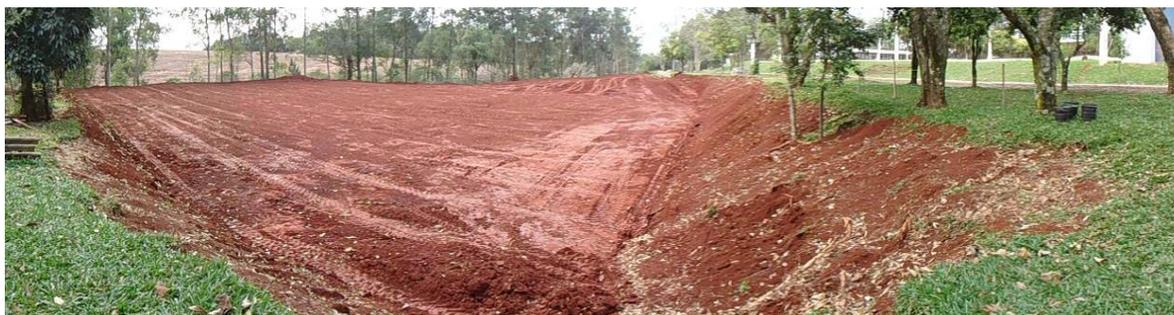
**Imagens da terraplanagem** que está sendo realizada no local onde serão construídos o campo de futebol sete sintético, a cancha de bocha de carpete e coberta e o novo conjunto de vestiários e quiosques, junto a Sede Campestre.
