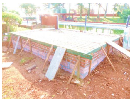
Reforma casa de bombas da piscina
