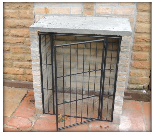
Realocação da Central de Gás
